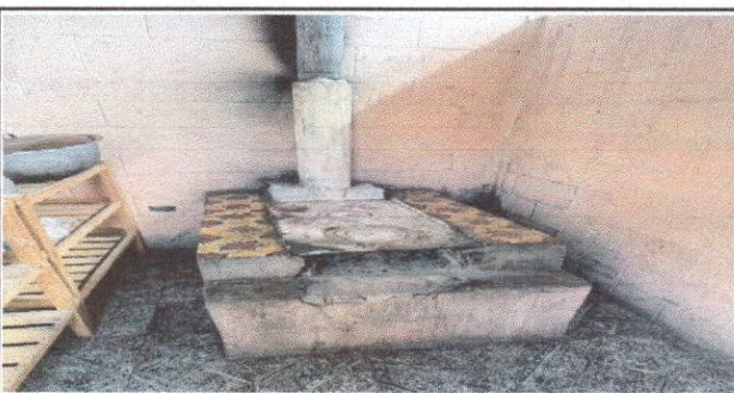
Foto 5: sustitución de plancha de tres hornillas.
