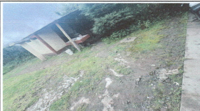
Foto 1: piso de torta de cemento
