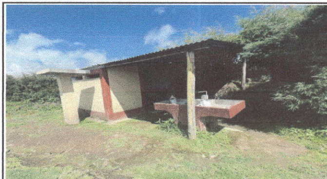
Foto 10: sustitucion de soporte de madera por metal
