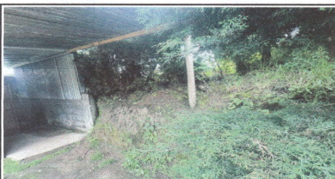
Foto 6: Sustitucion de muro perimetral de block 20 M2
